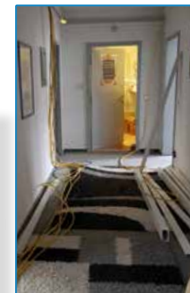
Ausbau des Netzwerkes
