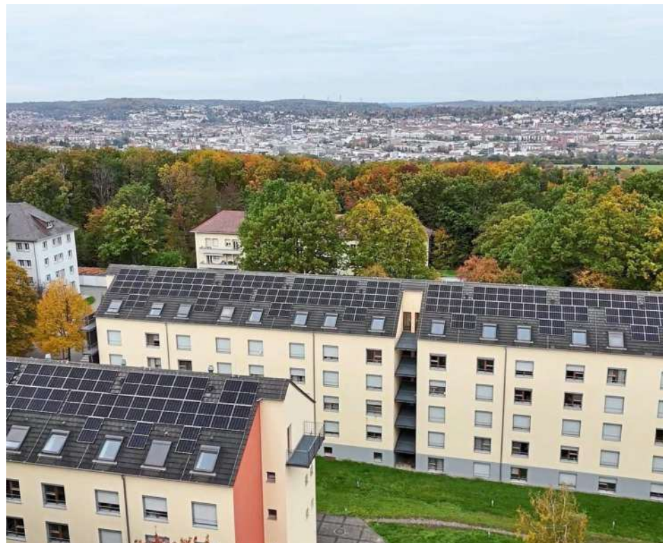
Voll im Zeitplan: Der Bau am Studentenwohnheim Hagenschieß begann im Juli 2025 und wurde pünktlich im Oktober abgeschlossen. Foto: Bogesch/Zipfl (SWP)
